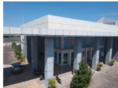
Gbr 3 Gedung A Akn
